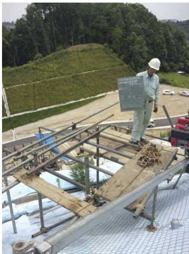
足場仮設状況
