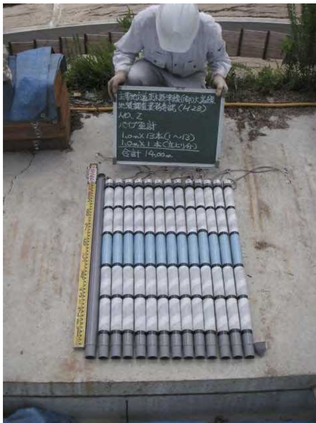
パイプ歪計検尺(全長14m)
