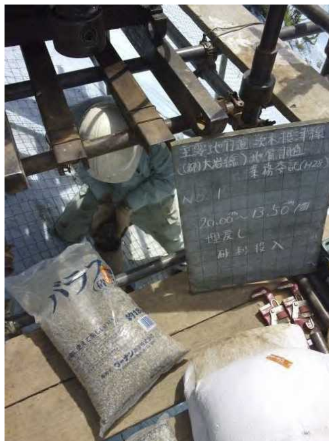
調査孔下部埋め戻し
