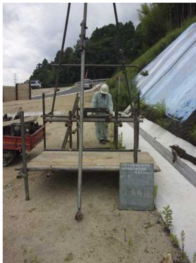
足場仮設状況
