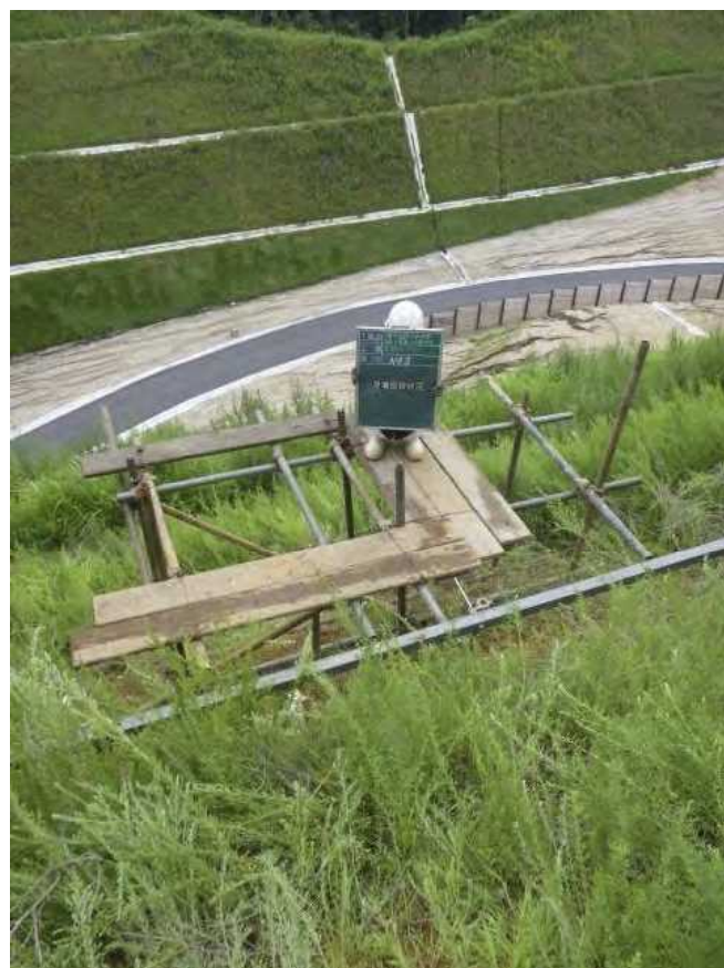
足場仮設状況
