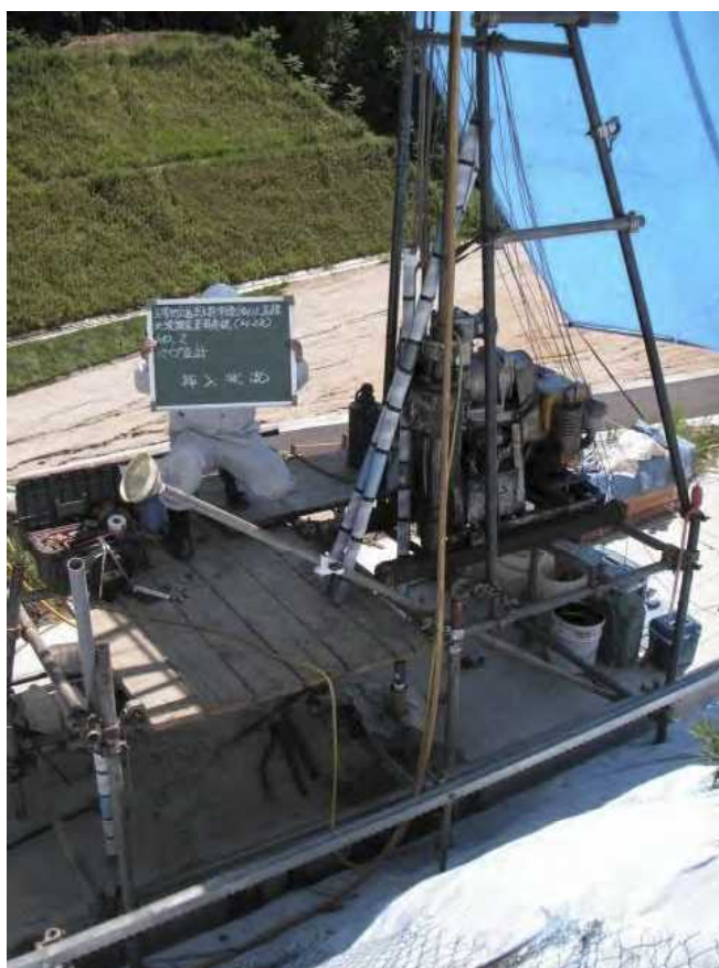
パイプ歪計挿入中
