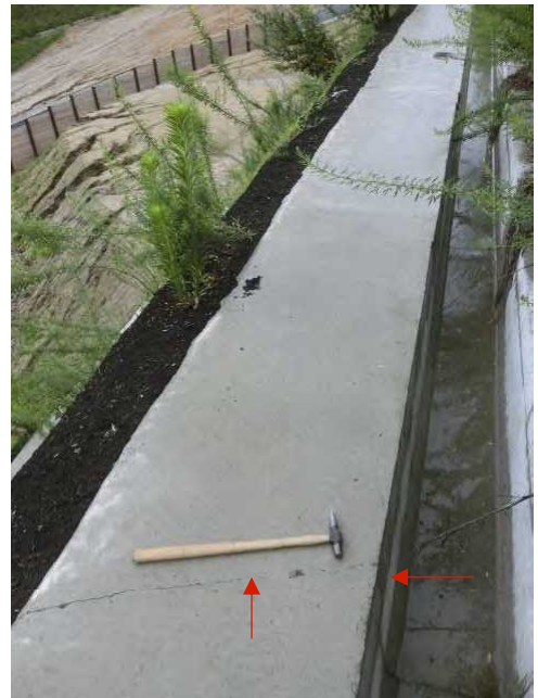
写真 41 4 段目小段コンクリート亀裂・横移動・沈下
