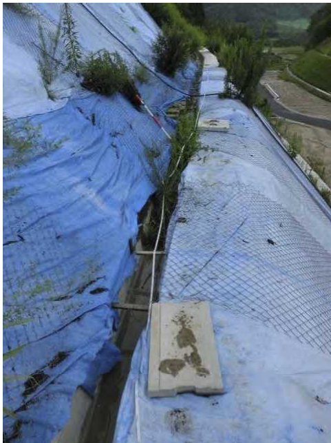
写真 40 4 段目小段の全景
