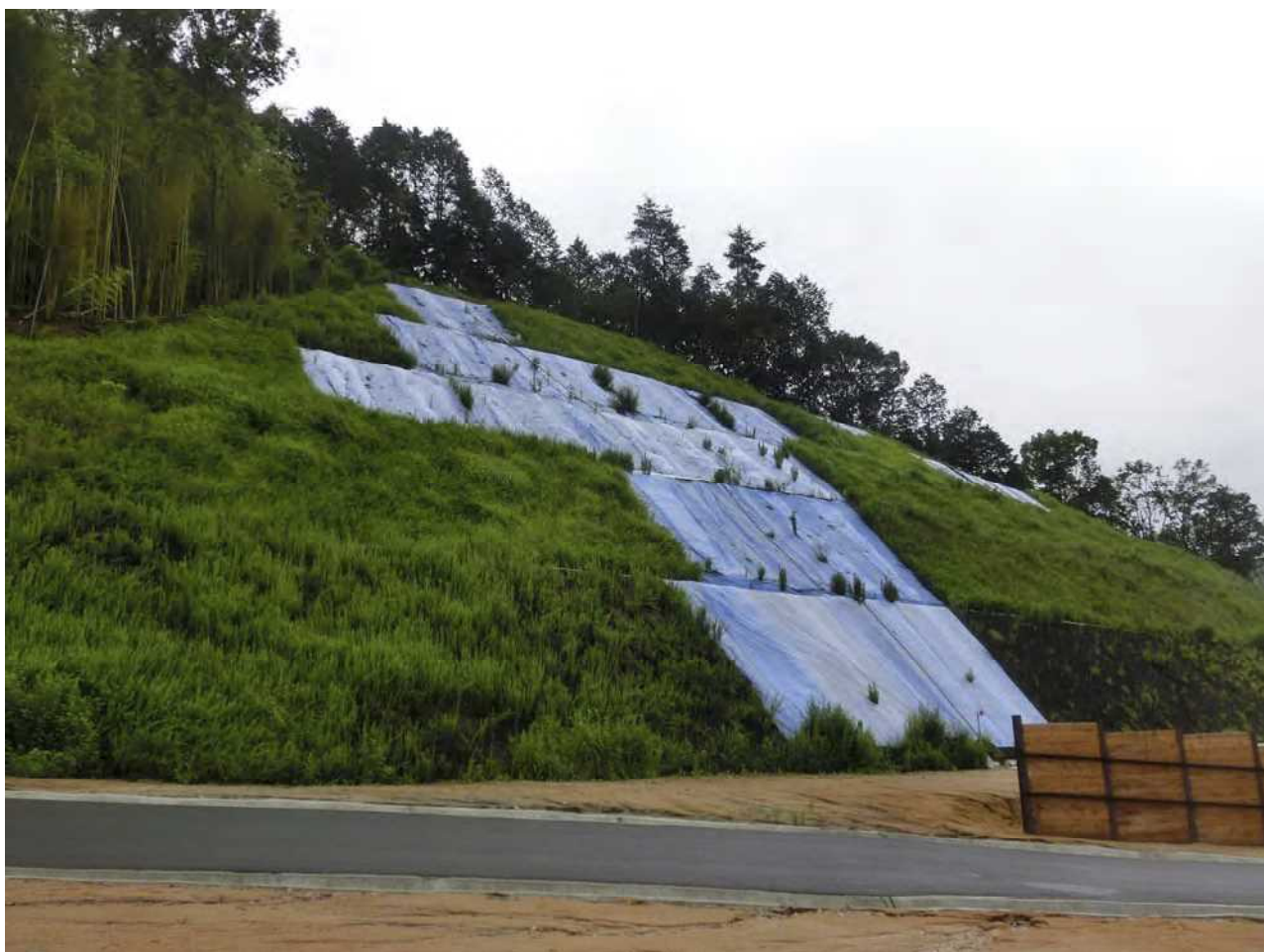
（写真 B）調査地法面全景写真
