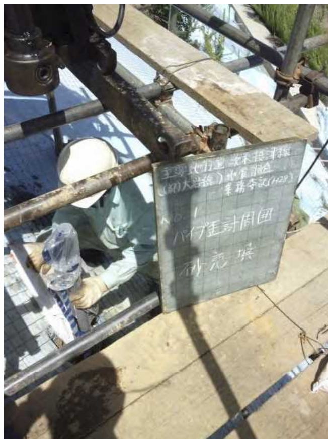
パイプ歪計周囲に砂充填
