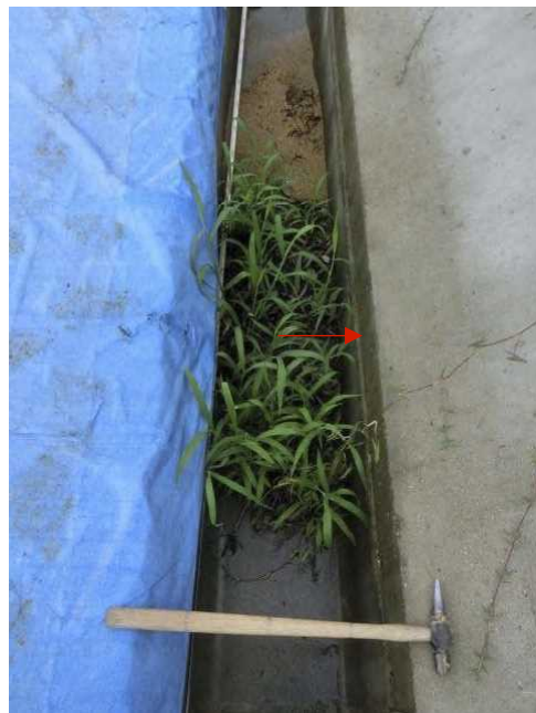
写真4 小段排水溝の押し出し
