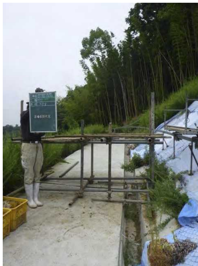
足場仮設状況
