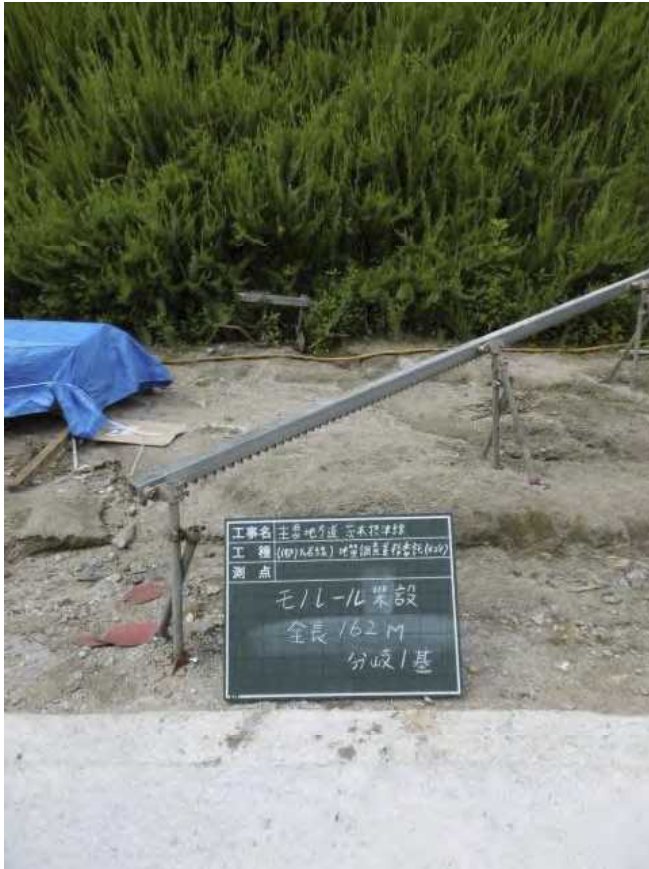
仮設状況（総延長162m）
