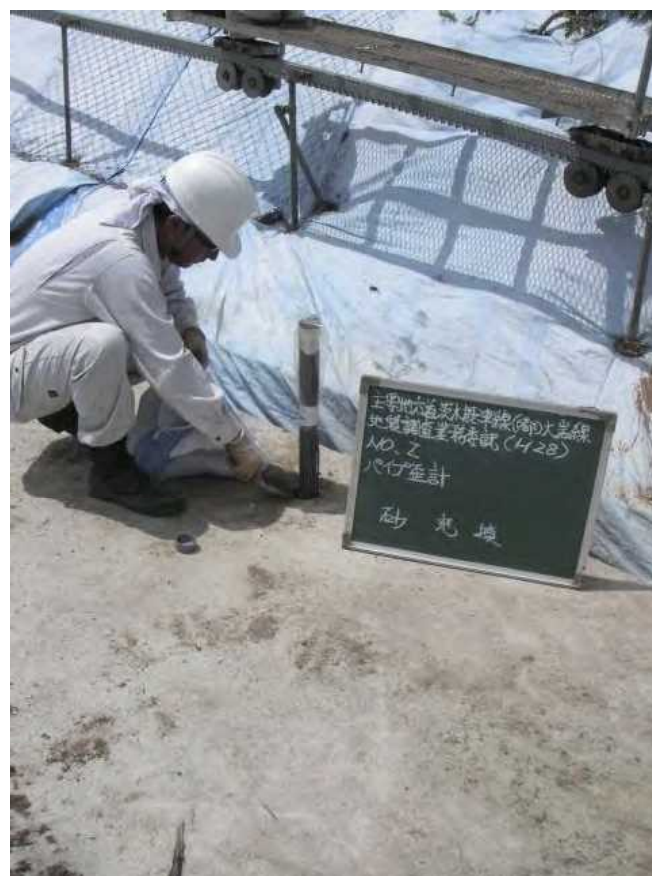
パイプ歪計周囲に砂充填
