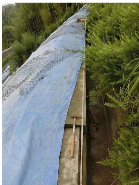
写真11 1段目小段コンクリート傾斜
