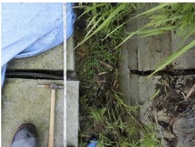
写真 17 2 段目小段、目地の開口
