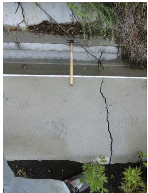
写真 41 4 段目小段コンクリート亀裂・横移動・沈下
