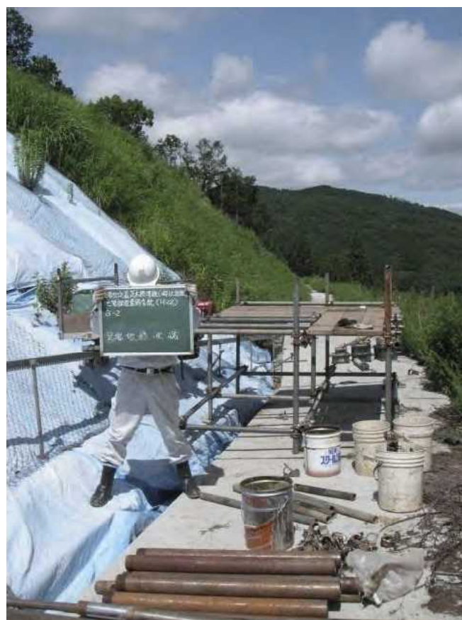
足場仮設状況
