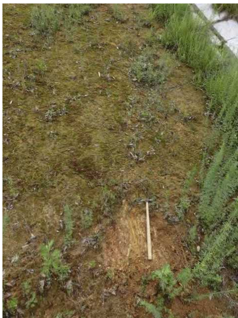
写真7 1段目法面にみられる小断層
