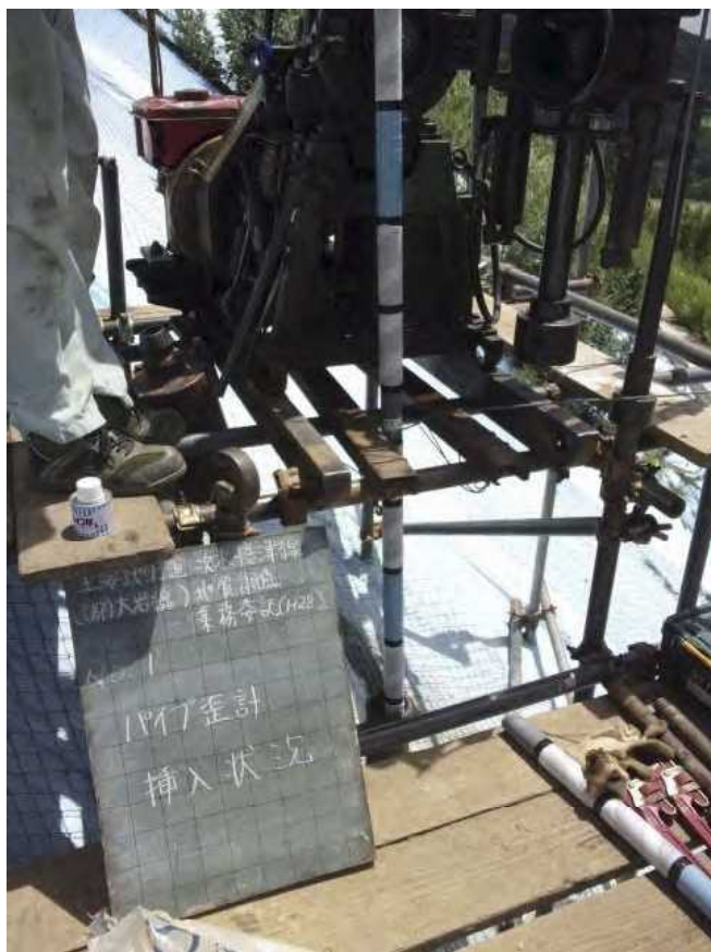
パイプ歪計挿入中
