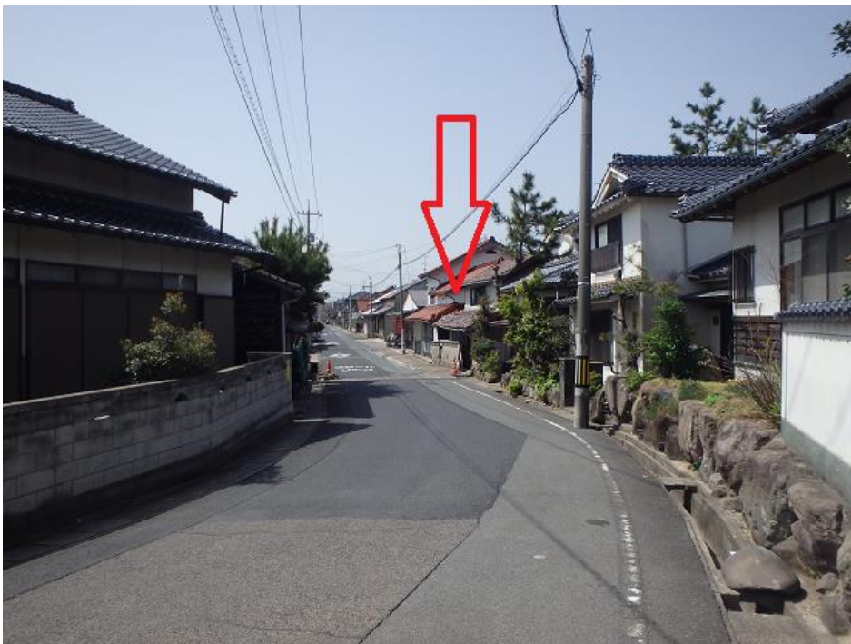
図5. 沈下した住宅（矢印）の遠望 手前から住宅方向に向けて道路が下がっている。 ここはかつて湖（波根湖）だった場所を干拓・盛土をして住宅が建てられた場所。
