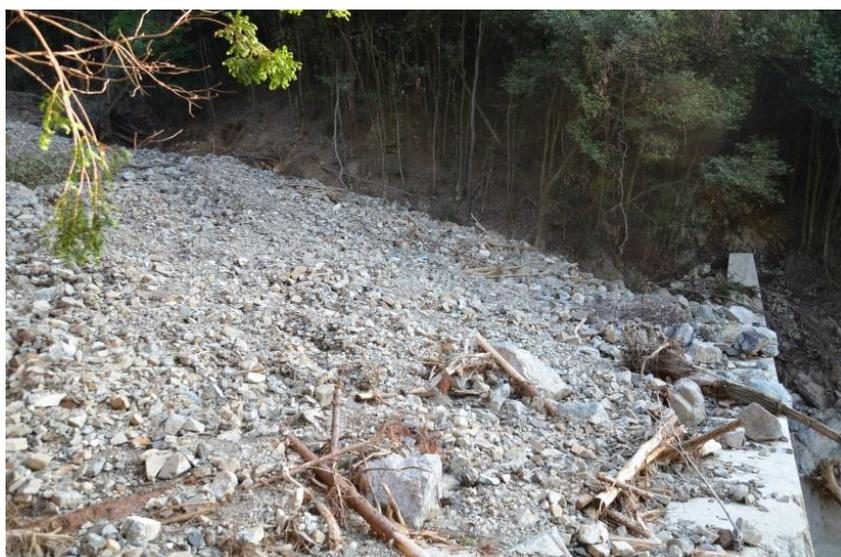
堰堤の上流部はご覧の通り満杯で、しかも堰堤の上の高さを目指して、ならしたように平らな斜面になっている。
