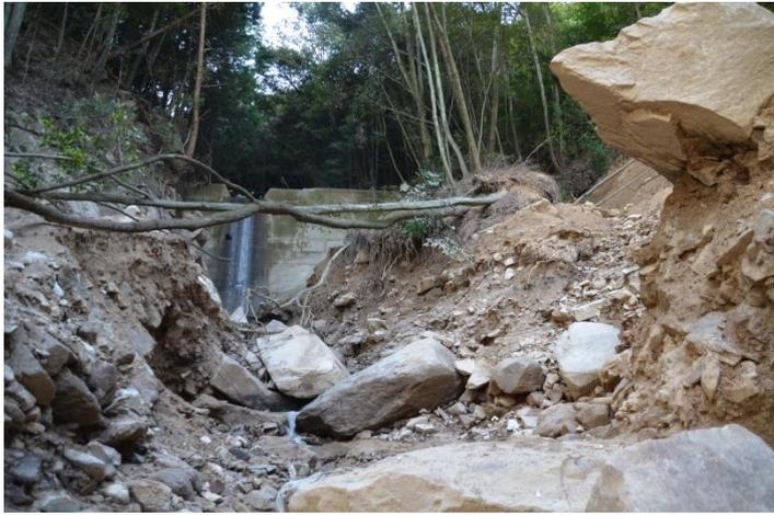
危険な崩落箇所をやり過ぎて下に降りて、下側からこの4番目の構造物を写したのがこれだ。かなりの高さを滝のように流れ落ちた土石流が大きな岩をも巻き込んで流れ下った様子が見て取れる。
